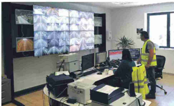
Panel de control de seguridad del túnel de Bielsa-Aragnoet.
