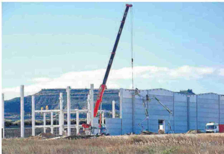
Obras de la planta que el grupo Sirvex está levantando en la Plataforma Logística de Fraga. HERALDO
