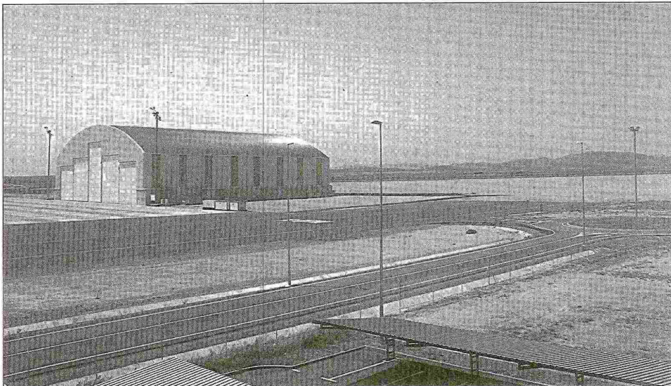
Vista general del hangar del aeródromo y, tras él, la plataforma de estacionamiento de aviones que será pavimentada
