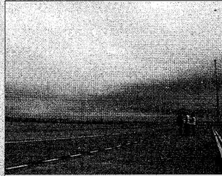
**Plataforma de mantenimiento.**- Destinada también al estacionamiento de corta estancia, ha requerido una inversión importante, porque el pavimento, de losas de hormigón, ha de soportar grandes pesos de aeronaves. Bajo el suelo, un sistema de drenaje filtra y recoge el agua con residuos y grasas procedentes de los aviones para darles el tratamiento adecuado.
