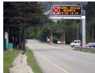
El túnel de Bielsa se reabrió al tráfico el pasado 19 de junio
