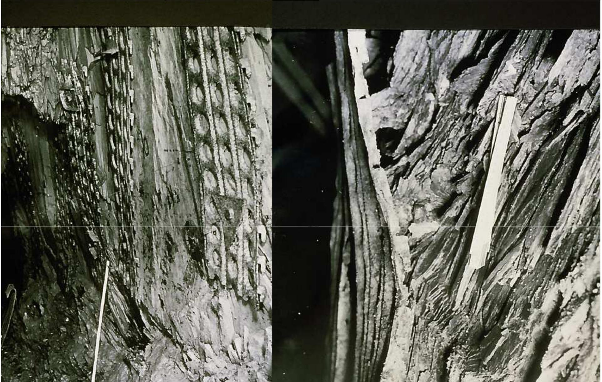
**à 300 m de profondeur, les schistes « flambent »,
